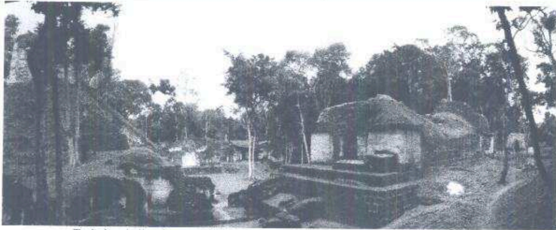
Trabajos de limpieza en edificios con arquitectura expuesta en Nakum.
