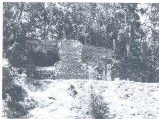
Edificio D, Nakum, bóvedas restauradas
