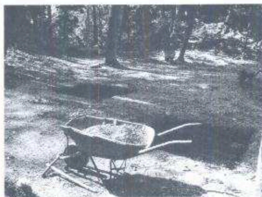
Excavación de pozos de sondeo en Hormigas Blancas
