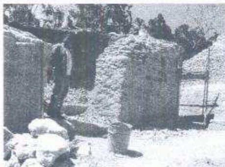
Estr. 3-S fachada norte y recinto 1
