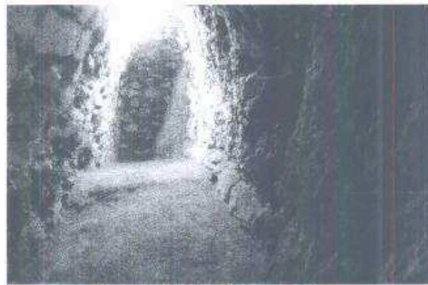
Túnel de edificio C-9, ramal norte
