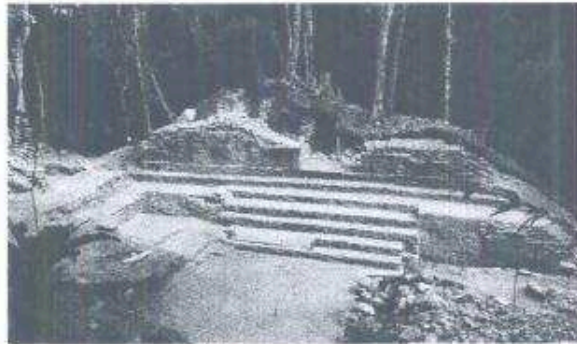
Edificio A-7 restaurado
